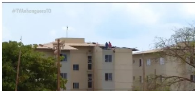
Telhado de bloco de apartamentos foi parcialmente arrancado pelo vento — Foto: Reprodução/TV Anhangüera
