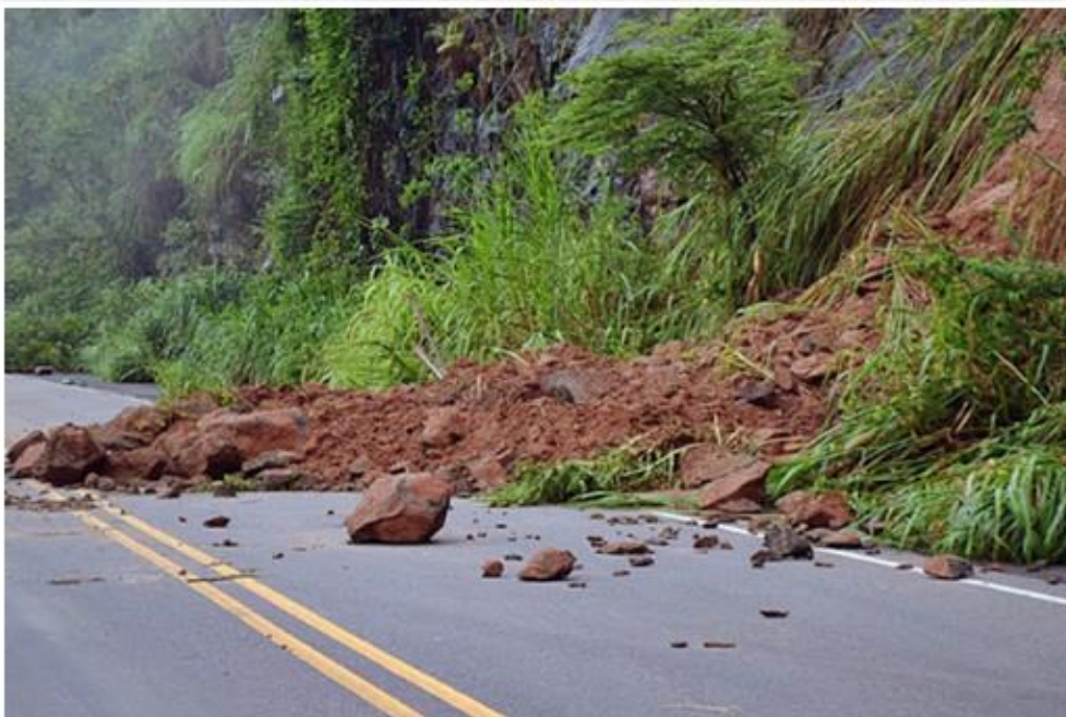
Deslizamento na BR-356, próximo a entrada da comunidade do Batatal. Foto: Rádio Muriaé
