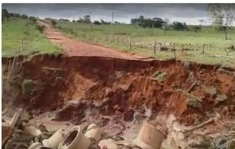
Cratera em Novo Horizonte do Sul (MS) causou estragos na tubulação de água (Foto: Reprodução/TV Morena)
