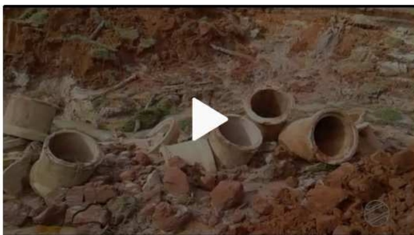
Chuva forte causa estragos em Novo Horizonte do Sul, MS
