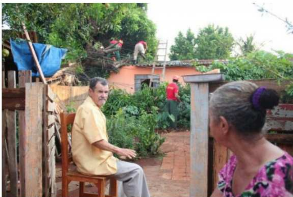
Pé de manga do terreno ao lado, caiu na casa dos idosos, danificando o telhado. (Foto: Marcos Ermínio)
