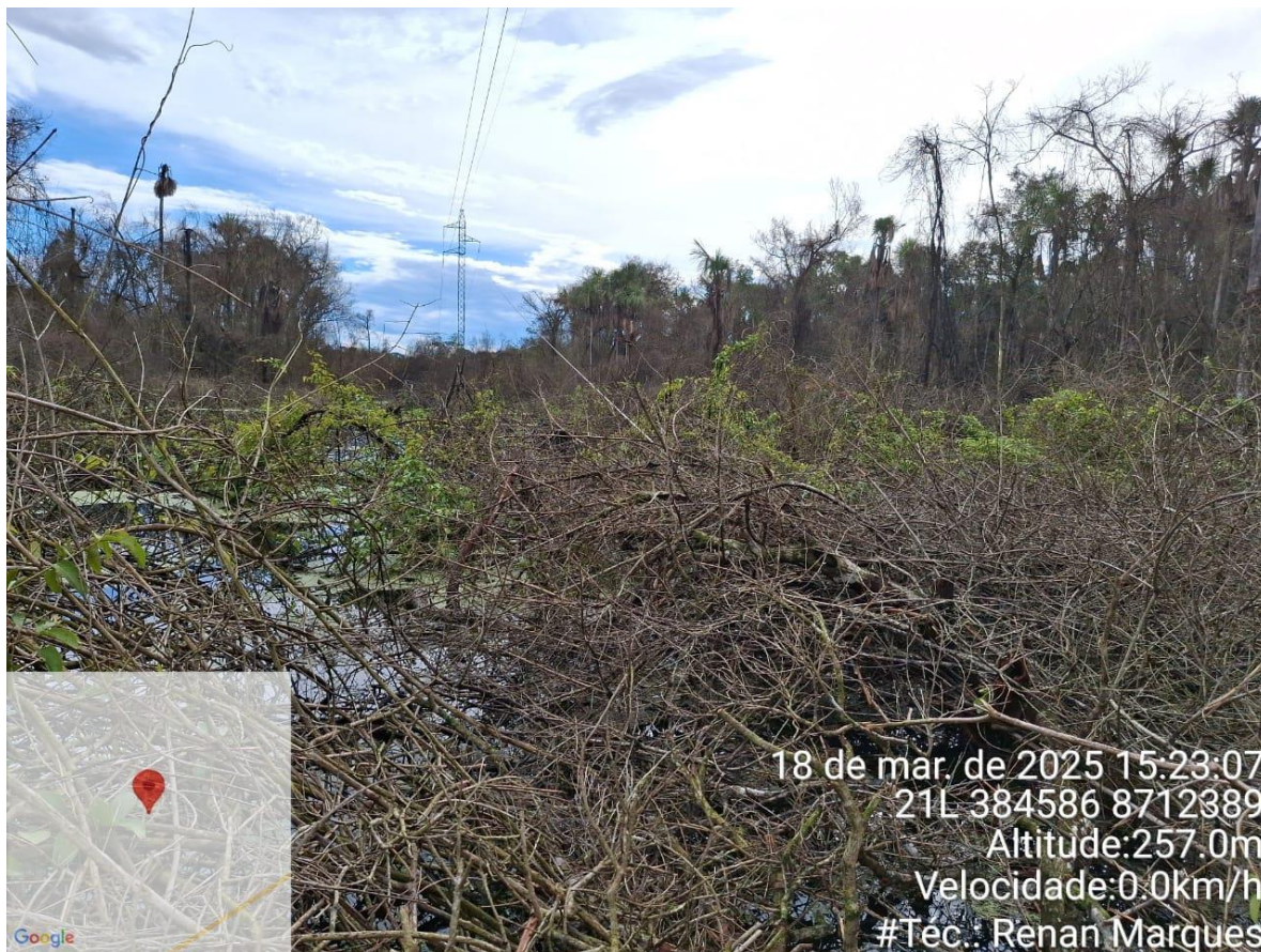
Figura 68 - Região alagada com interrupção de energia elétrica
