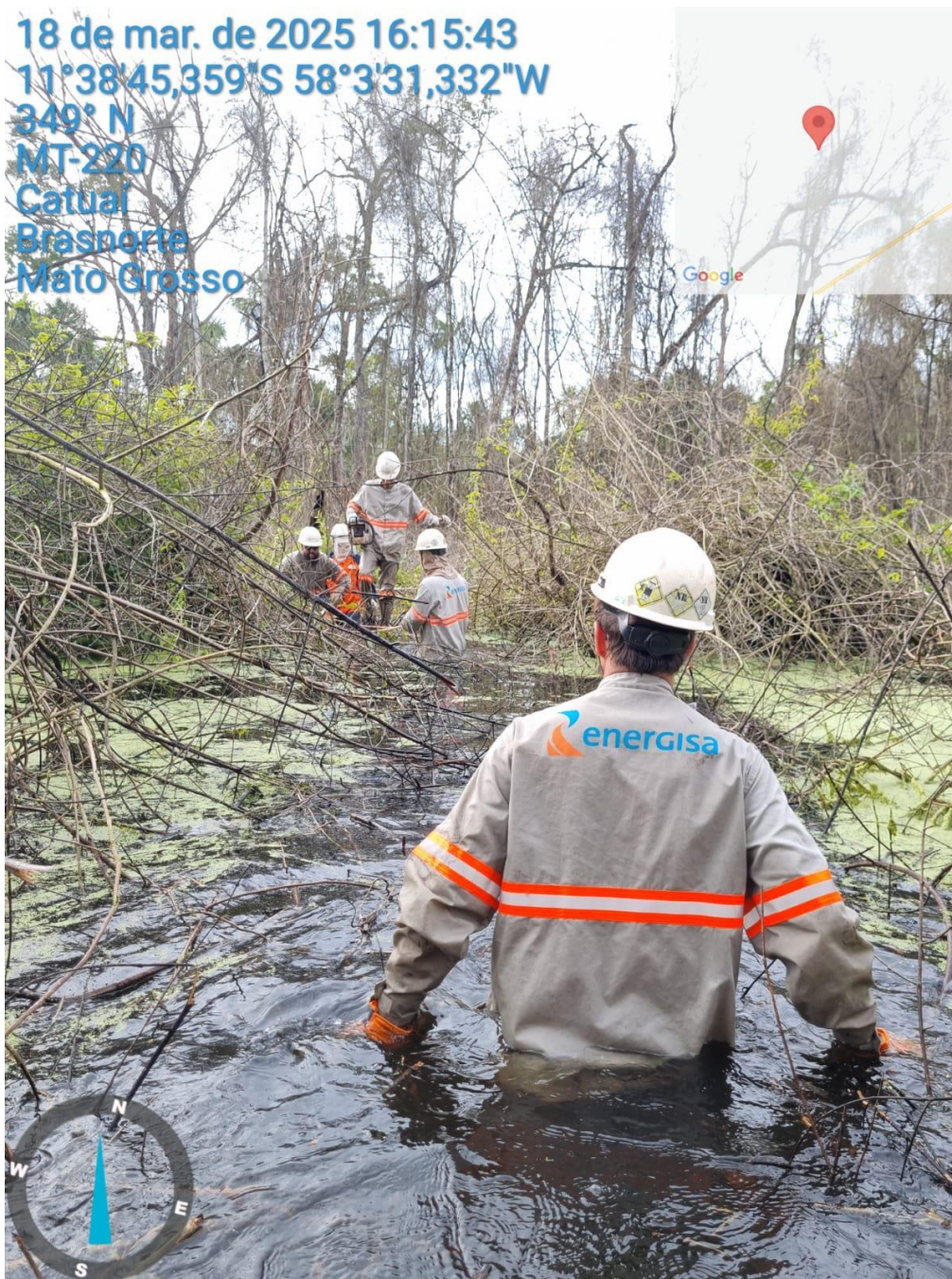
Figura 67 - Equipe de eletricitas trabalhando em área alagada
