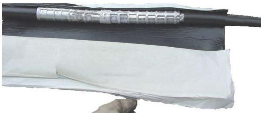
Figura III. Processo de decapagem e marcação do condutor.
