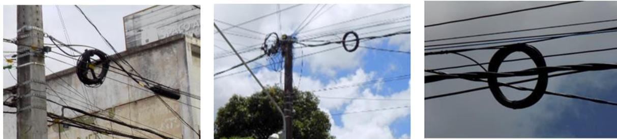
Figura 06. Instalações irregulares de reversas técnicas tipo cruzeta.
