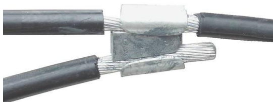
Figura IV. Processo de decapagem e marcação do condutor.
