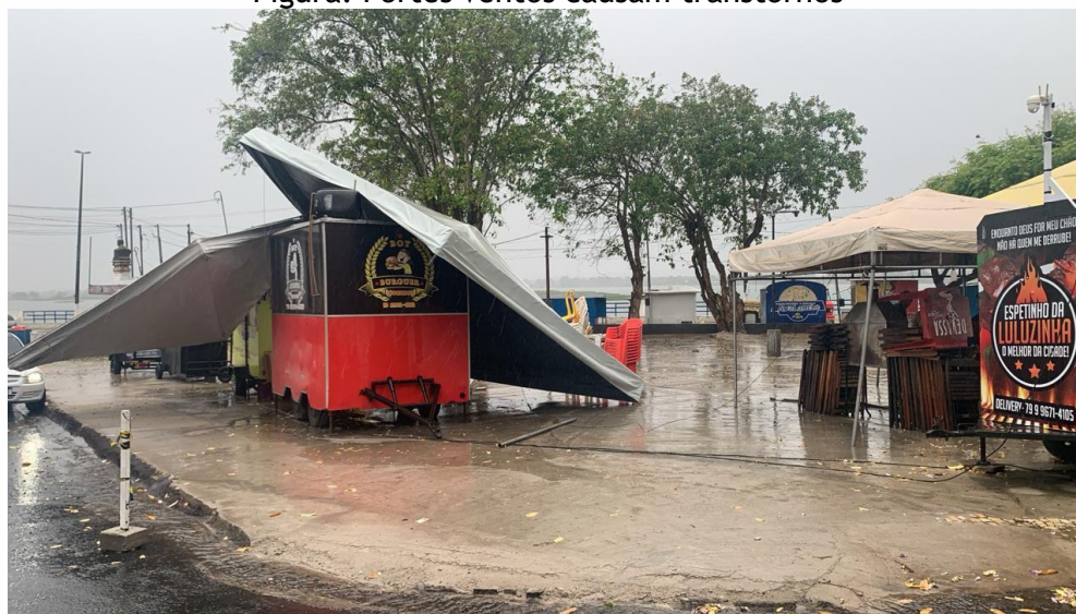
Fonte: Equipes Energisa
