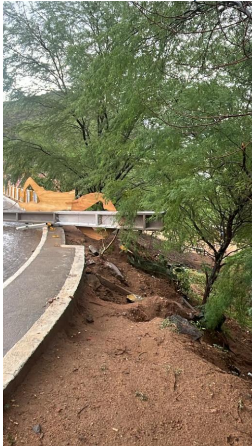
Fonte: Equipes Energisa
