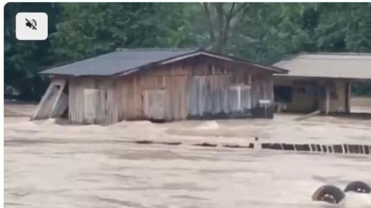
Casas é arrastada e ponte derrubada após forte temporal em MT
